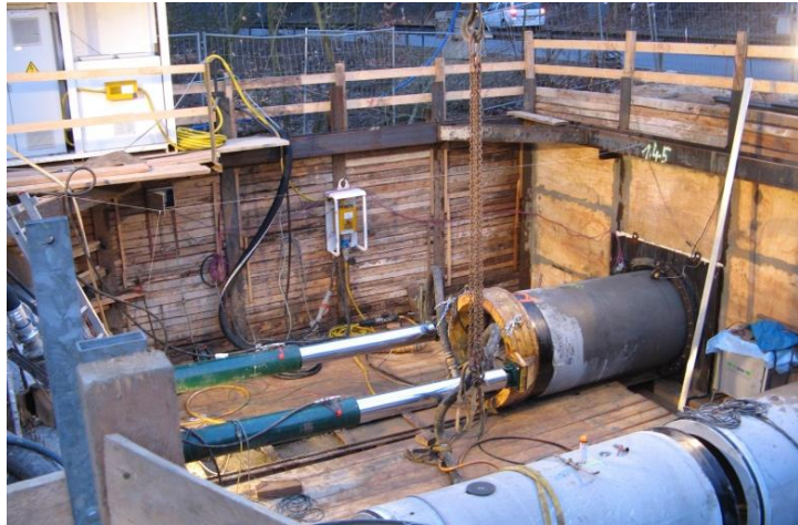
Startgrube der Rohrpressung
